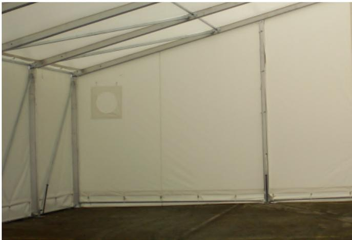
4 Stk. Heizungseinlässe, als Standard bei jedem Euroflex, garantieren einen optimalen Anschluss von Heiz- und Belüftungsgeräten
