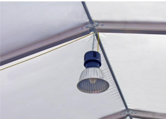
Mit den 400W starken Gasentladungsleuchten kann man das Zelt optimal und Stromsparend ausleuchten.
